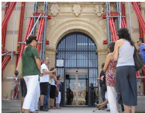
Lorca Abierto por Restauración. Lorca (Murcia). 2011.
